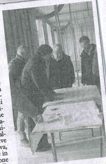
CANTIERE Il punto sui lavori all'interno del centro diurno di Migliarino
