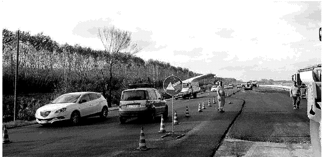
Le auto sono tornate a circolare sull'Aurelia dove è in corso l'ultima asfaltatura
