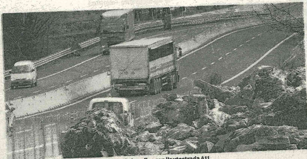
La frana che si è abbattuta su via dei Salcetti al confine con l'autostrada A11
